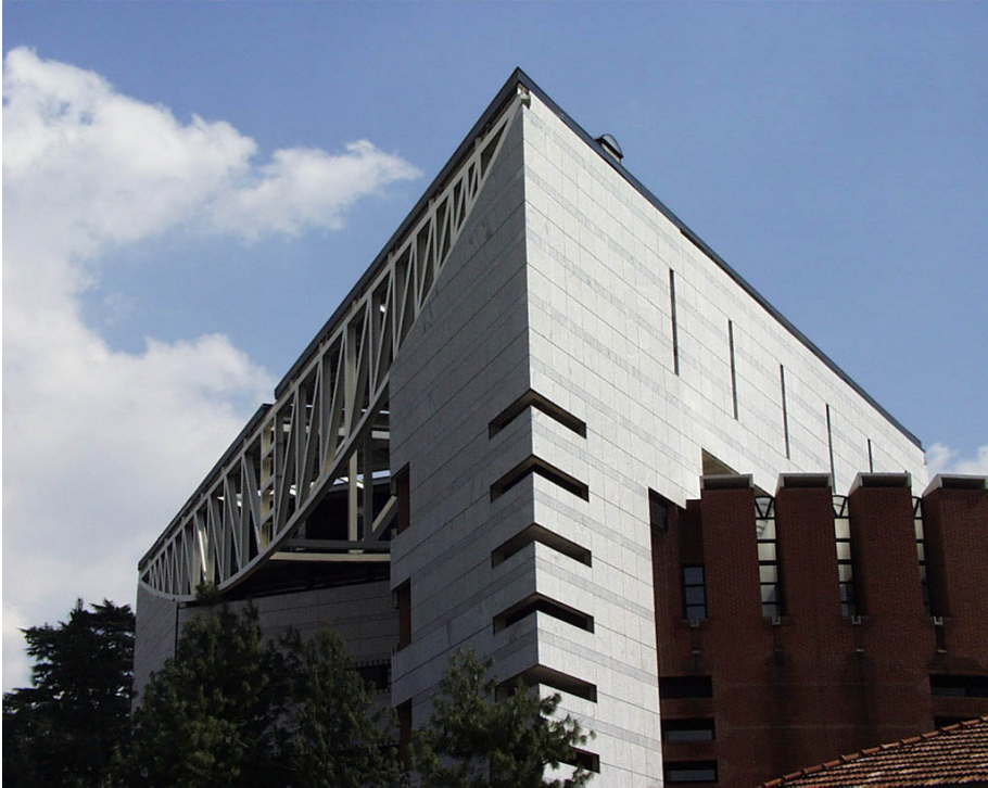
L'edificio di via Valleggio 11 in Como, Sede dell'Amministrazione del Dipartimento di Scienze Chimiche e Ambientali.
